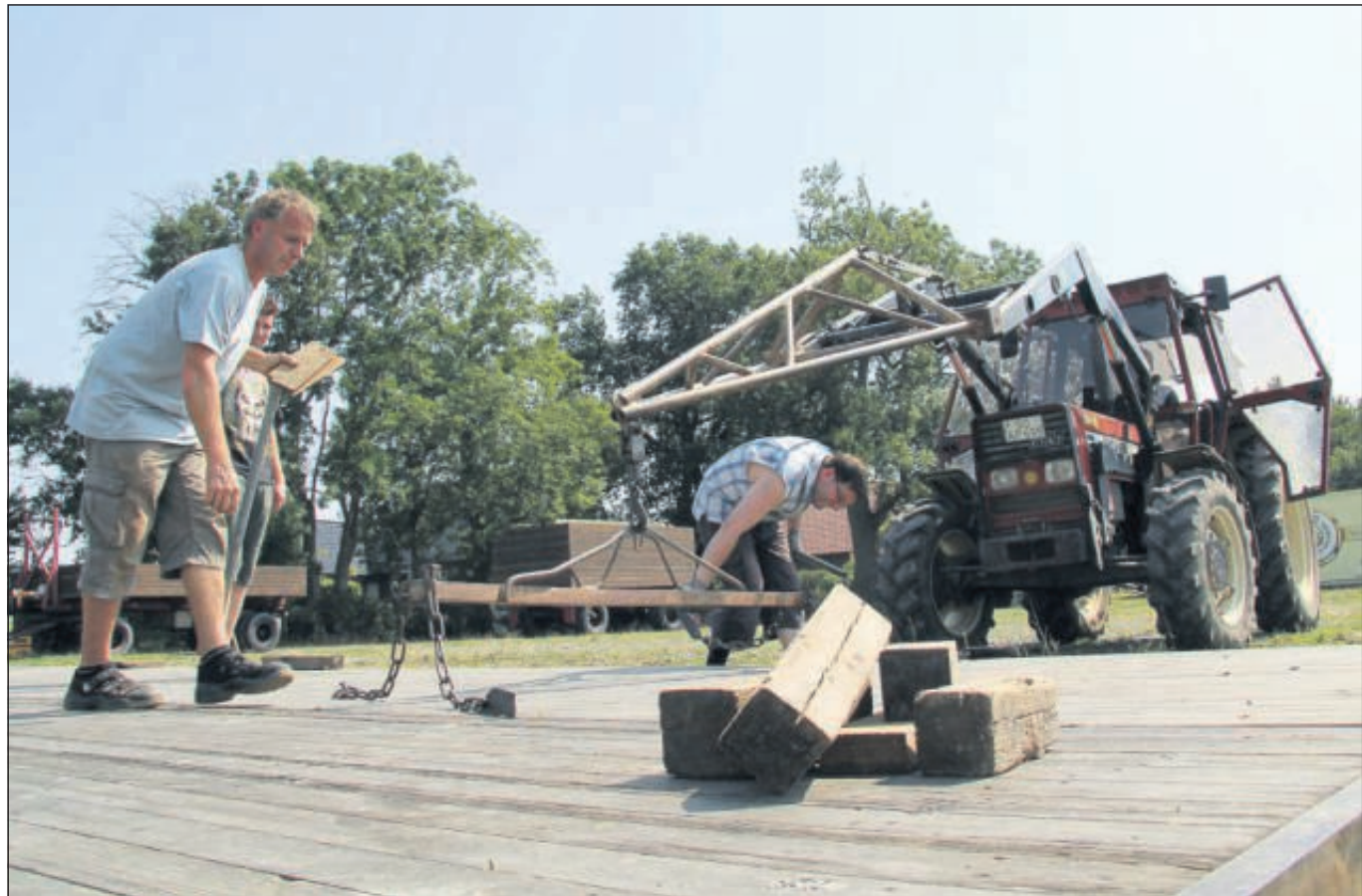
Platte für Platte entsteht auf einem Feld in Westereiden langsam das Schützenzelt. Oberst Franz-Bernhard Meyer transportiert sie mit einem Traktor heran, die übrigen Schützen bringen sie in Position und verankern sie. ■ Fotos: Mund
